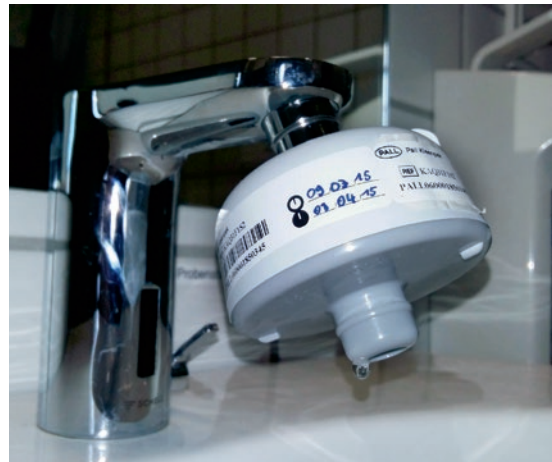
Abb. 5: Zur unmittelbaren Gefahrenabwehr bei hohen mikrobiologischen Kontaminationen können auch im außermedizinischen Bereich temporär Sterilfilter eingesetzt werden, soweit sich der Filterabgang mindestens 20 mm über der Keramik befindet (DVGW twin 12). Sanitärarmaturen mit bedarfsabhängiger Stagnationsspülung unterstützen den bestimmungsgemäßen Betrieb (im Bild: elektronische Waschtisch-Armatur).
